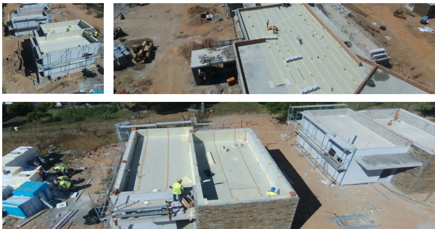
DRY80 waterproofing of roofs in Lentiscais. Castelo Branco. Portugal.
